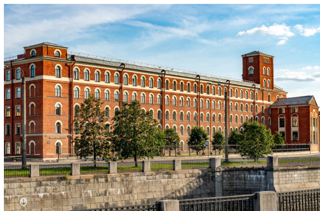
Наб. Обводного канала, д. 60
